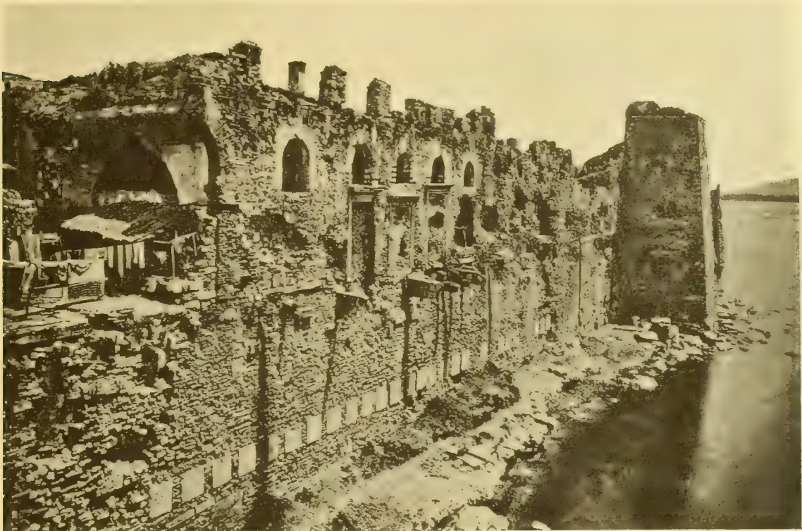
Abb. 351. Die Seemauer von Byzanz mit Baugliedern des Hormisdaspalastes.
