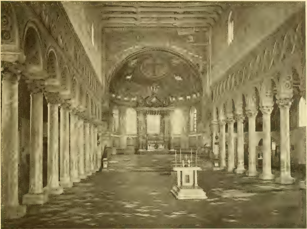
Abb. 343. S. Apollinare in Classe (Ravenna), Durchblick durch das Hauptschiff in den Altarraum.
