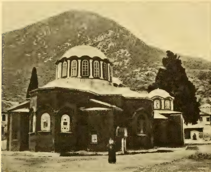
Abb. 403. Das Katholikon von Lawra (Athos), Ansicht von Nordosten (nach N. Kondakow, Die christlichen K.-Denkm. des Athos, 1902).
